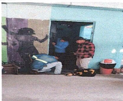
Foto 9: Mejoramiento de puerta de metal.
