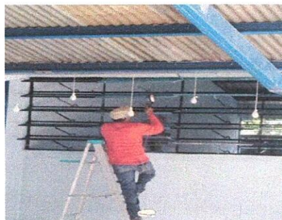
Foto 6: Mejoramiento de pinturas de ventanas.
