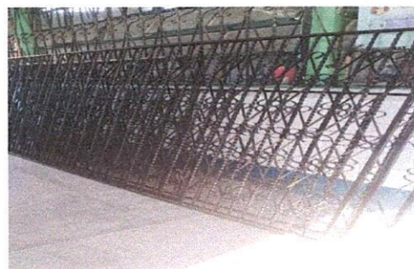
Foto 8: Mejoramiento de balcones en módulo 2
