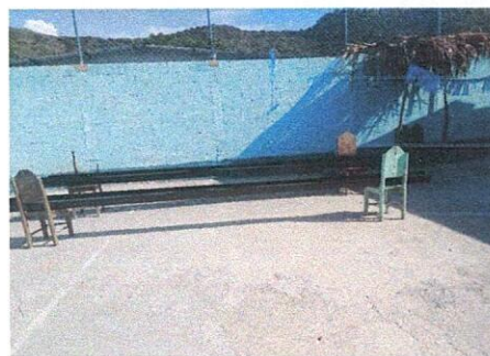
Foto 4: Instalaciones de canales de caída de aguas pluviales.
