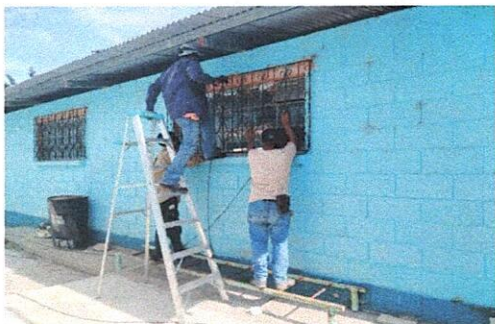
Foto7: Mejoramiento de pintura en balcones módulo 1
