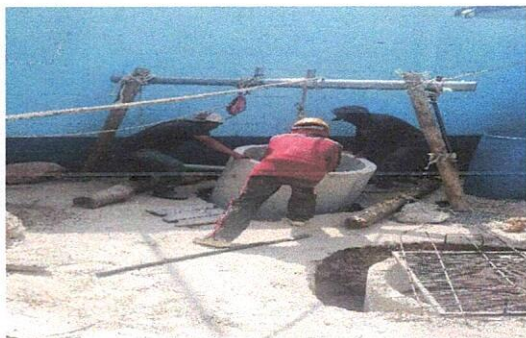
Foto1: Perforación y elaboración de la fosa séptica.
